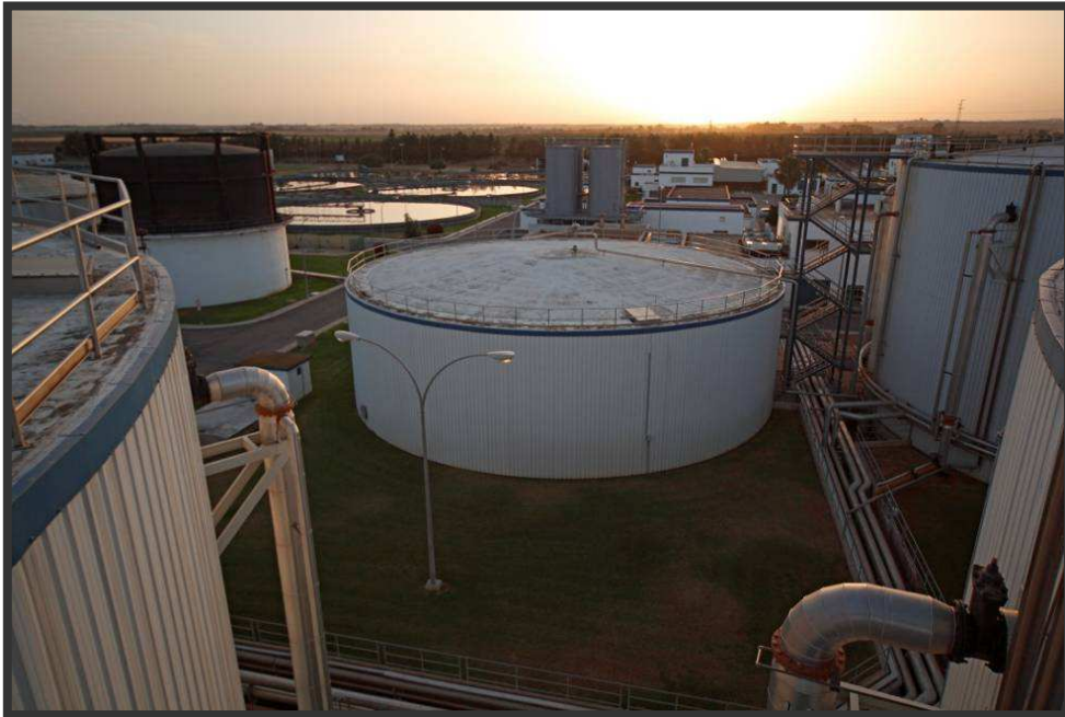
Foto 1. EDAR Copero, vista de la zona de digestión y gasómetro
